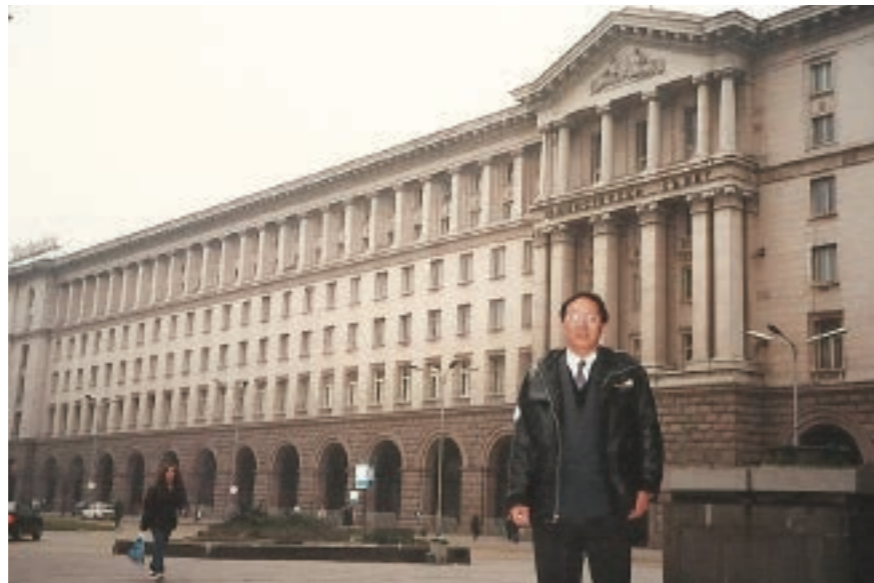
东欧剧变后的原政府大楼
