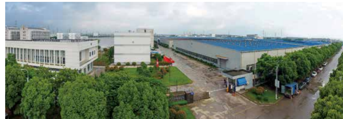
组图：欧圣电气的厂房外景和内景
