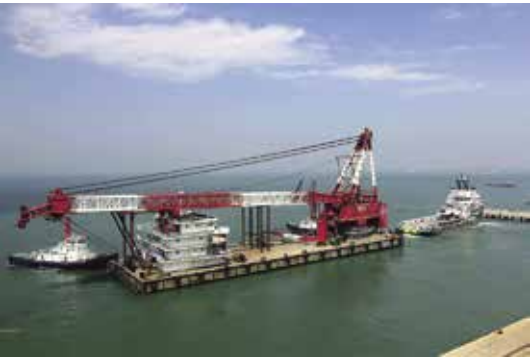
2015年4月15日，我国中标承建最大国际桥梁孟加拉国吉大港帕德玛大桥主桥建造工程增添新设备，最大起重重量1000吨级浮吊船“瑞航05”在山东青岛海西重机有限责任公司码头顺利办理完海关通关手续，从青岛驶向孟加拉国
