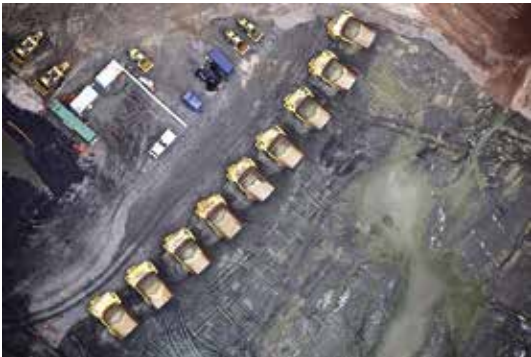
英国欣克利角核电项目建设工地。欣克利角C核电项目是英国20年以来第一个新建核电站，由中法两国企业共同投资建设，将使英法两国核电工业共同受益
