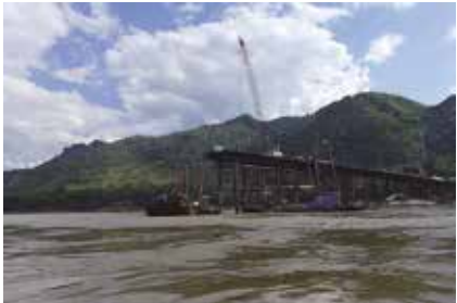
中国施工队在湄公河上架桥修建中老高铁
